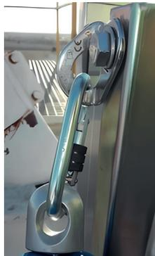
*Nota.* Ejemplo de un anclaje anti caídas temporal.
