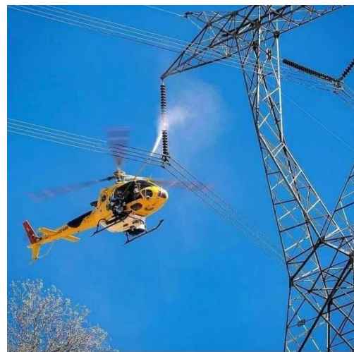
Figura 23: Mantenimiento de Aisladores de Alto voltaje.
