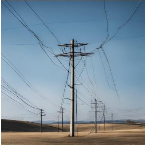
Figura 8: Poste de hormigón para bajo voltaje
