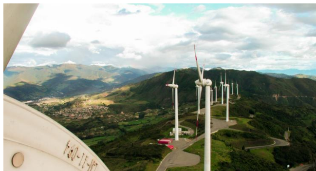
Figura 26 Parque eólico ubicado en Villonaco - Loja
